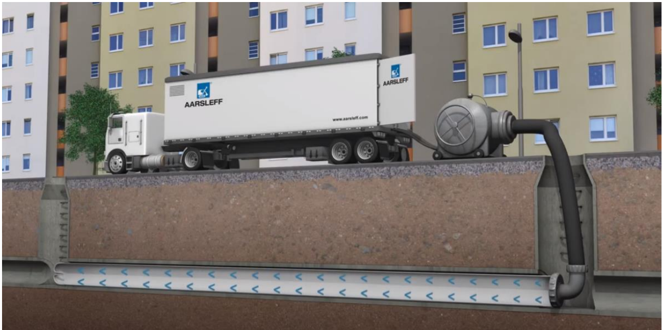
Figur 7 Renovering af eksisterende kloakker i Stenløse uden at grave vejene op.
